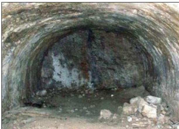
*Une citerne encore visible sous les vastes bâtiments en ruine. Tout le crépi d'étanchéité est encore intact.*
