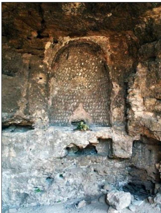
*Niche tapissée de coquillages, au fond de la nef. Elle est trop haute (1,5m) pour servir d'autel. Le scellement des coquillages commence à se dégrader sérieusement. L'analyse du mortier rouge de scellement permettrait sans doute une datation : XIII<sup>ème</sup> ou XVII<sup>ème</sup> siècle ?*
