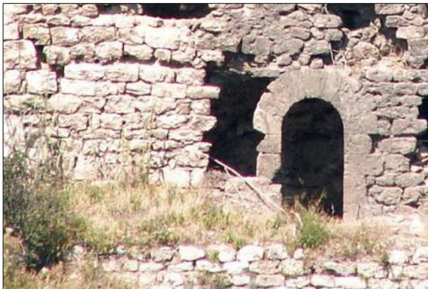
*Appareillage en travertin de la porte.*
